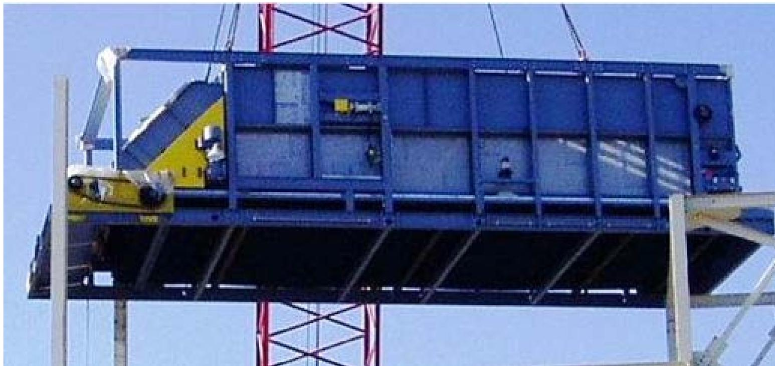
Бункер устанавливается перед линией формовки и используется для ее постоянного заполнения щепой и волокном.
