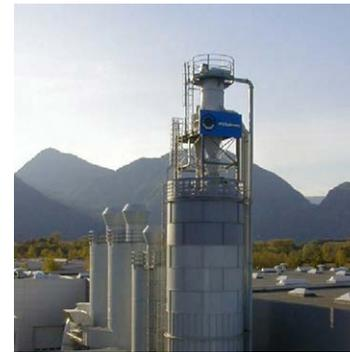
La ciclatura dell'aria permette di separare le particelle grossolane per effetto dell'elevata velocità del flusso d'aria che di conseguenza riduce la quantità di polvere che deve essere filtrata dalle maniche. Un sistema di lavaggio automatico ad aria compressa pulisce le maniche. La forma cilindrica e la serie di portelli di sovrappressione conferiscono all'impianto un'elevata resistenza all'esplosione.
