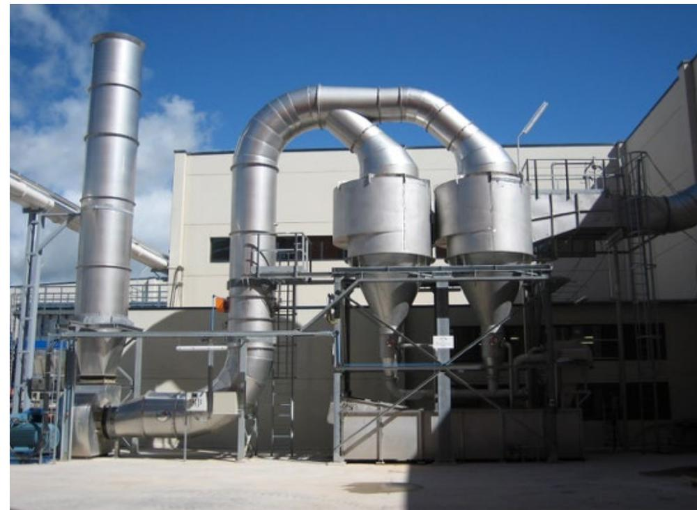
Il sistema di aspirazione dei fumi della pressa è installato sulla pressa continua responsabile della produzione di pannelli in modo da minimizzare i rischi di incendio. Infatti, il fuoco potrebbe essere causato da depositi di sostanze nei fumi liberati durante il processo di pressatura del pannello di legno.
