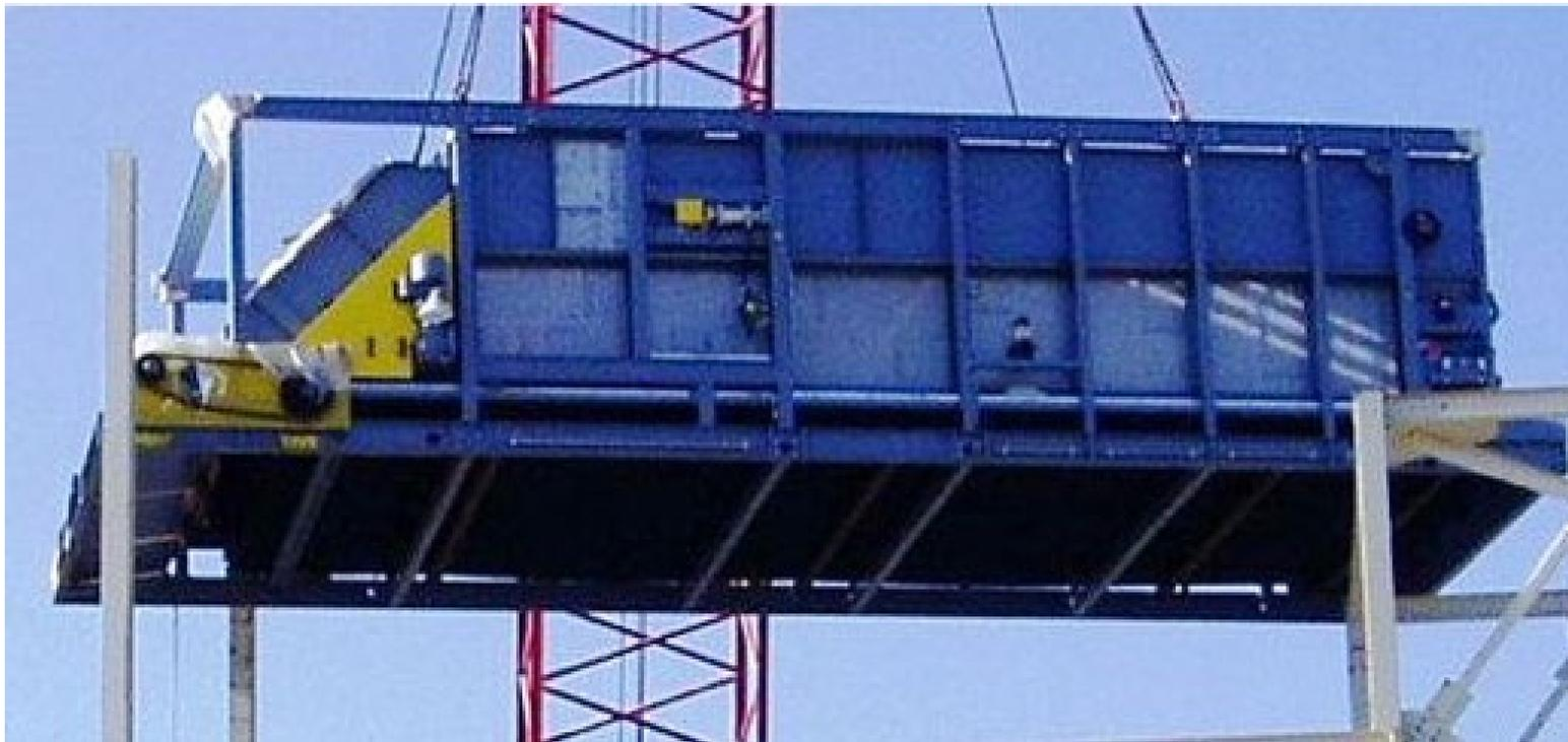
Il bunker viene installato prima della formatrice, ed è utilizzato per rifornirla costantemente con chips e fibre.
